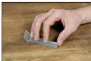
8. Ahmen Sie die Maserung ggf. mit einem dunkleren Farbton nach. Wiederholen Sie in diesem Fall anschließend Schritt 7.
