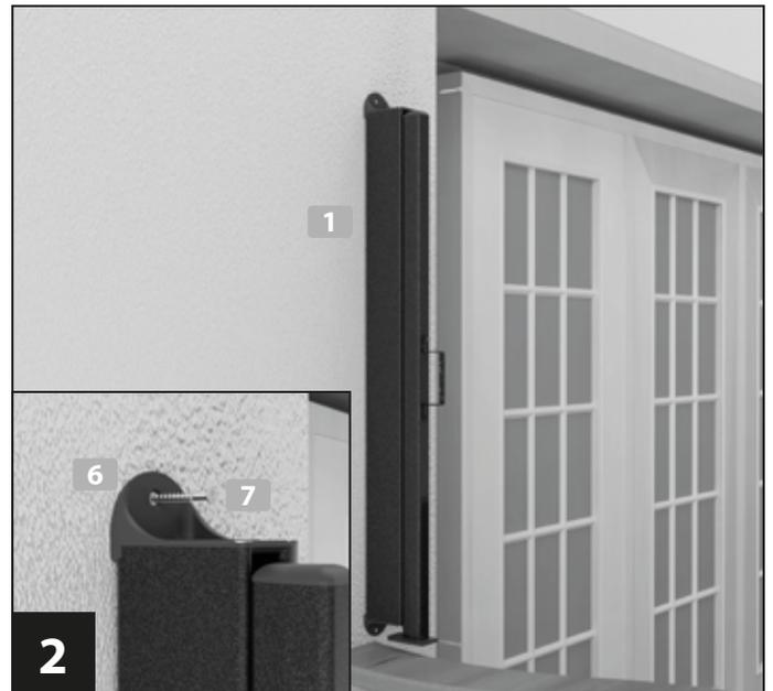
Setzen Sie die Dübel **6** ein und befestigen Sie die Balkonmarkise **1** mit den Kreuzschlitzschrauben **7**.
